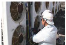
室外機の点検・検査
