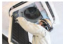
新しいエアコンへの入替
