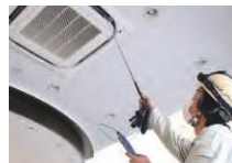
エアコン本体の点検・検査
